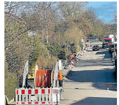
Glasfaserausbau in der Schulstraße Foto: Stadt Öhringen
